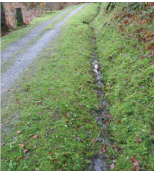
auch Rinnen werden freigelegt, so dass das Wasser wieder abfließen kann
